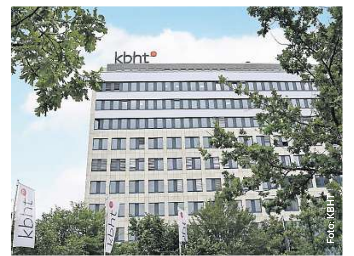
Die Erweiterung des KBHT-Hauptsitzes am Europadamm ist ein Bekenntnis zum Standort Neuss.
